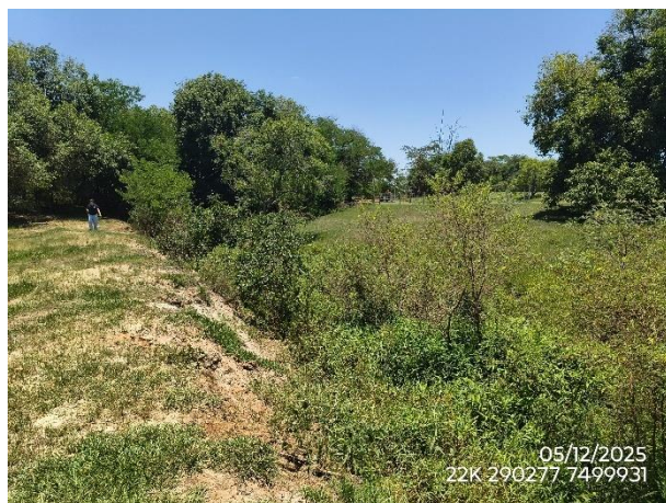
Foto 07 – Canal de drenagem com fluxo lento, e cerca de 2,5m de profundidade. Entorno com vegetação rasteira, solo arenoso e árvores no limite com a Rua Antonio Goterrez Messa.
