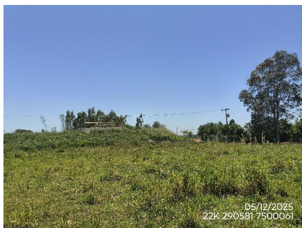
Foto 05 – Estação de Tratamento de Esgoto da SABESP junto ao limite Sudeste da área de estudo.
