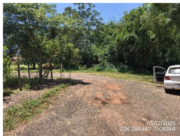
Foto 12 – Detalhe para condições precárias de drenagem urbana no bairro Vila Áurea, contíguo à área de estudo.
