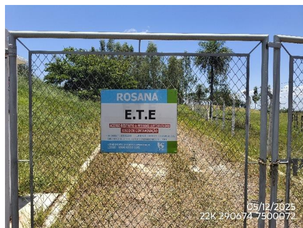
Foto 06 – Detalhe para entrada da Estação de Tratamento de Esgoto junto à área de estudo.
