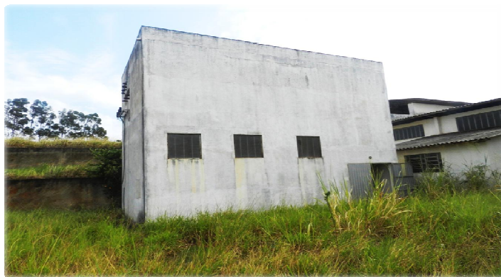
Prédio da Cabine de Energia (frente)
