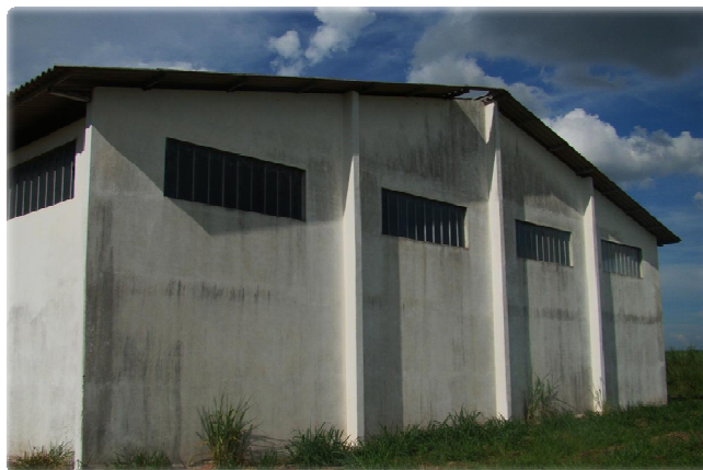
Lateral do Armazém
