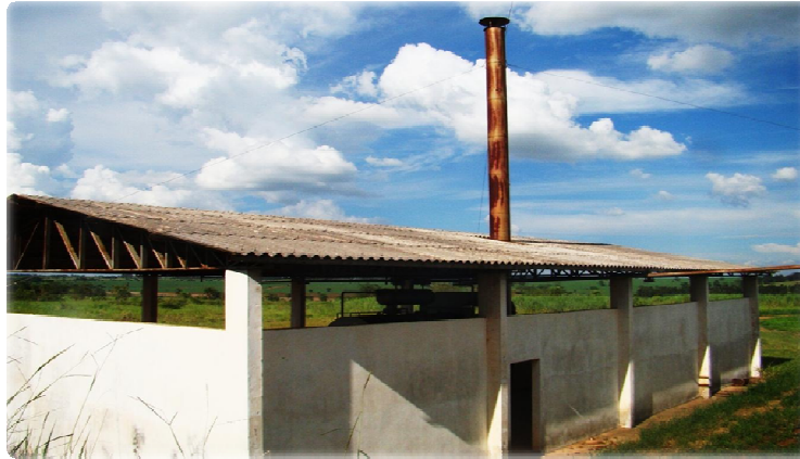
Barracão da Caldeira Externo
