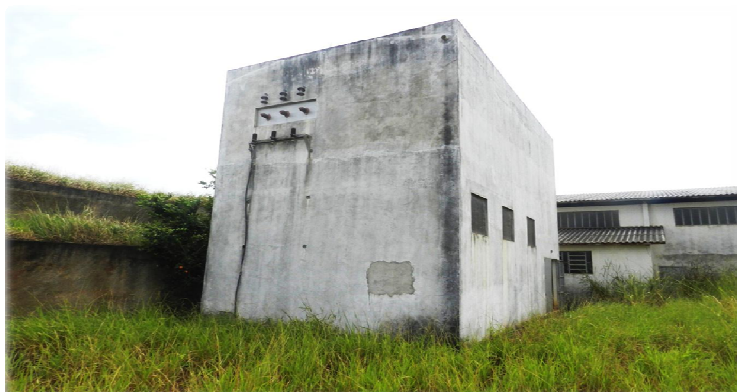
Prédio da Cabine de Energia (Lateral)
