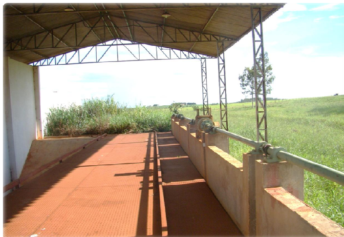
Barracão da Rampa de Descarga de Raízes com cobertura
