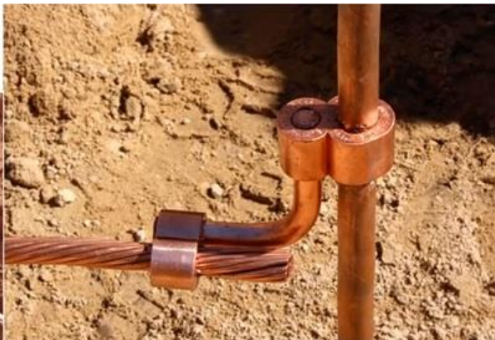
Circuito de proteção (terra) hastes de 5/8' com cordoalha de cobre nú de 70mm 2 .
