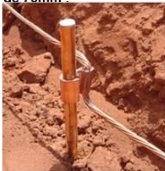
Circuito de proteção (terra) hastes de 5/8' com cordoalha de cobre nú de 70mm 2 .
