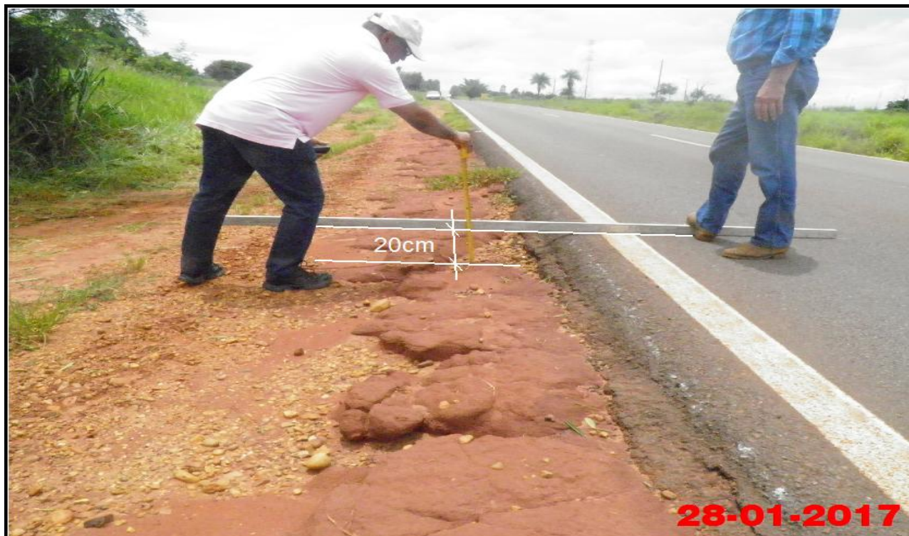
Foto 16 – Vista geral do desnível da Rodovia Arlindo Bértio (SP-613) com o seu acostamento do lado esquerdo no sentido à Rosana.
