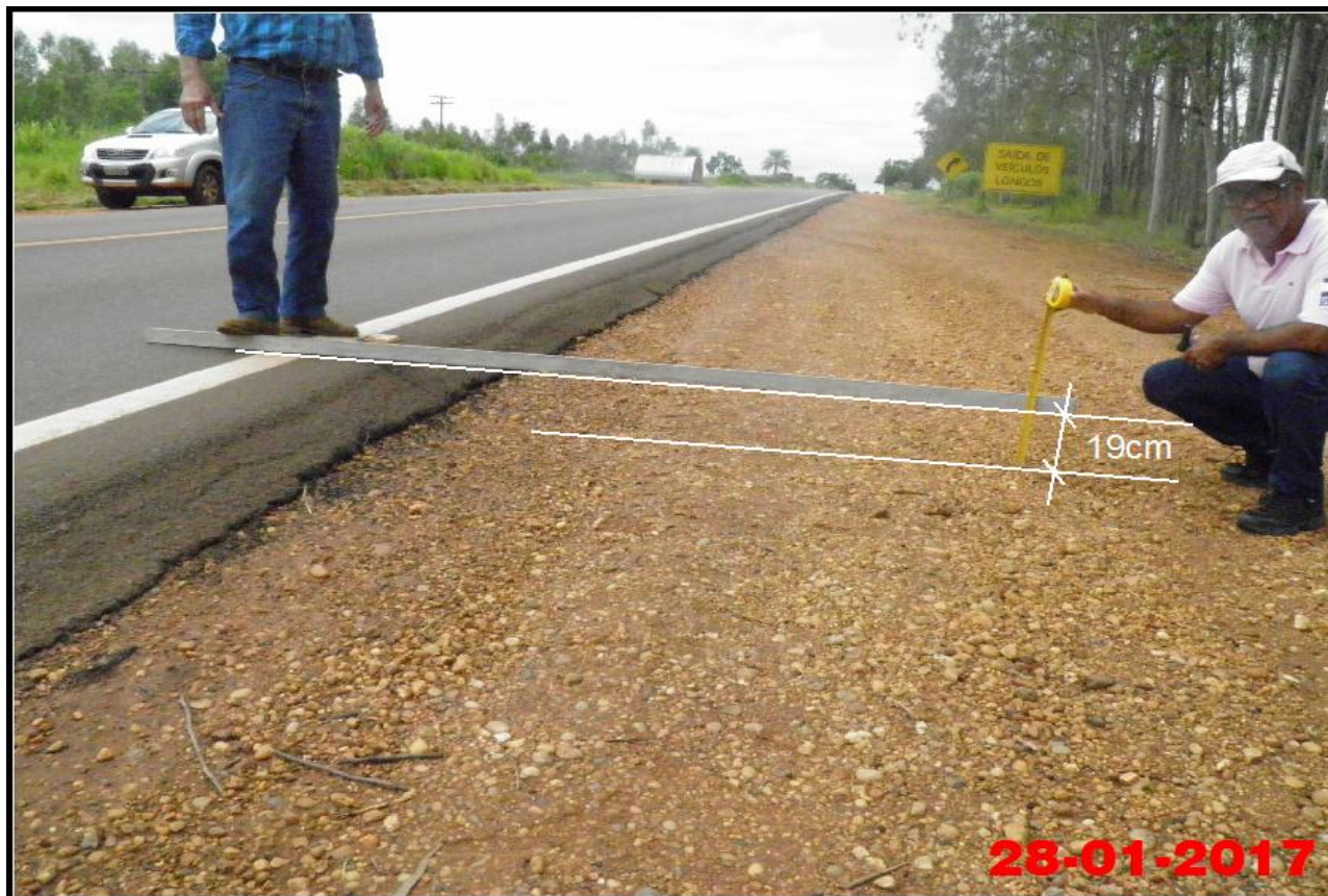
Foto 12 – Vista geral do desnível da Rodovia Arlindo Bértio (SP-613) com o seu acostamento do lado esquerdo no sentido à Rosana.
