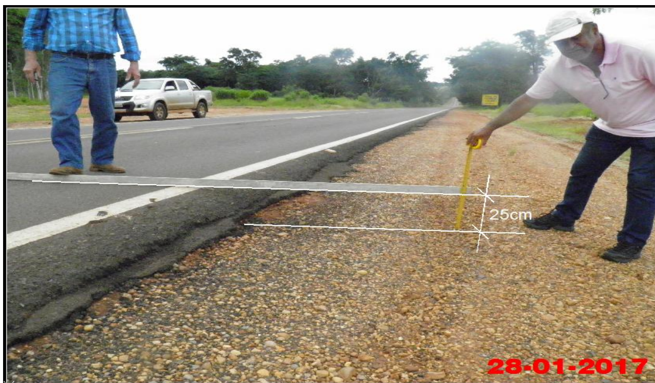
Foto 05 – Vista geral do desnível da Rodovia Arlindo Bétio (SP-613) com o seu acostamento do lado esquerdo no sentido à Rosana.
