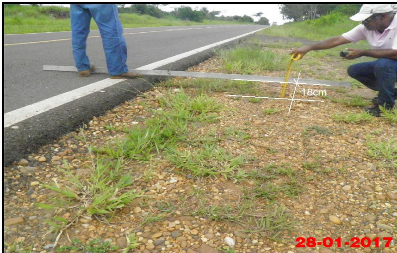
Foto 37 – Vista geral do desnível da Rodovia Arlindo Bétio (SP-613) com o seu acostamento do lado esquerdo no sentido à Rosana.
