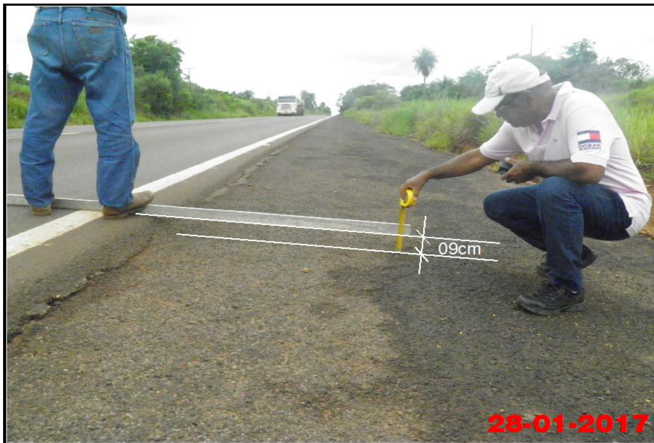
Foto 28 – Vista geral do desnível da Rodovia Arlindo Bértio (SP-613) com o seu acostamento do lado esquerdo no sentido à Rosana.
