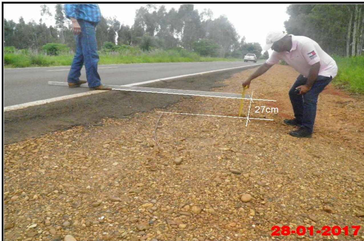
Foto 23 – Vista geral do desnível da Rodovia Arlindo Bétio (SP-613) com o seu acostamento do lado esquerdo no sentido à Rosana.
