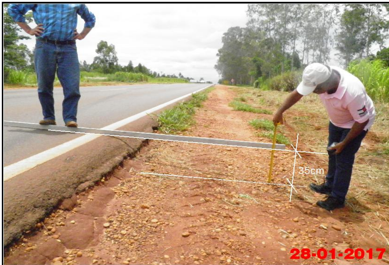
Foto 13 – Vista geral do desnível da Rodovia Arlindo Bétio (SP-613) com o seu acostamento do lado esquerdo no sentido à Rosana.
