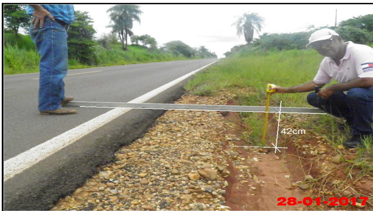
Foto 27 – Vista geral do desnível da Rodovia Arlindo Bértio (SP-613) com o seu acostamento do lado esquerdo no sentido à Rosana.
