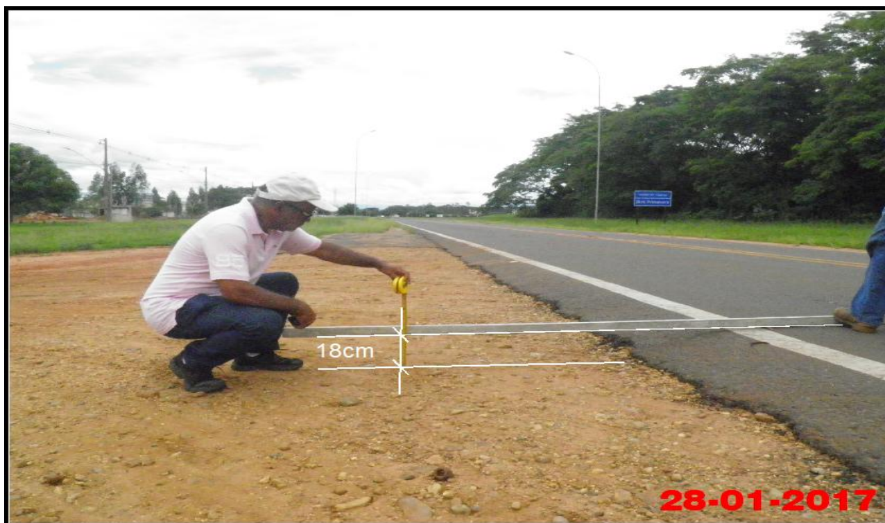
Foto 33 – Vista geral do desnível da Rodovia Arlindo Bétio (SP-613) com o seu acostamento do lado esquerdo no perímetro urbano de Primavera sentido à Rosana.
