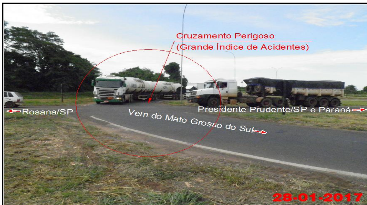
Foto N – Vista geral do cruzamento “perigoso” no trevo da (SP-613) Rodovia Arlindo Bétio, perímetro urbano de quem vem do Estado do Mato Grosso do Sul para o Estado do Paraná e Presidente Prudente/SP.
