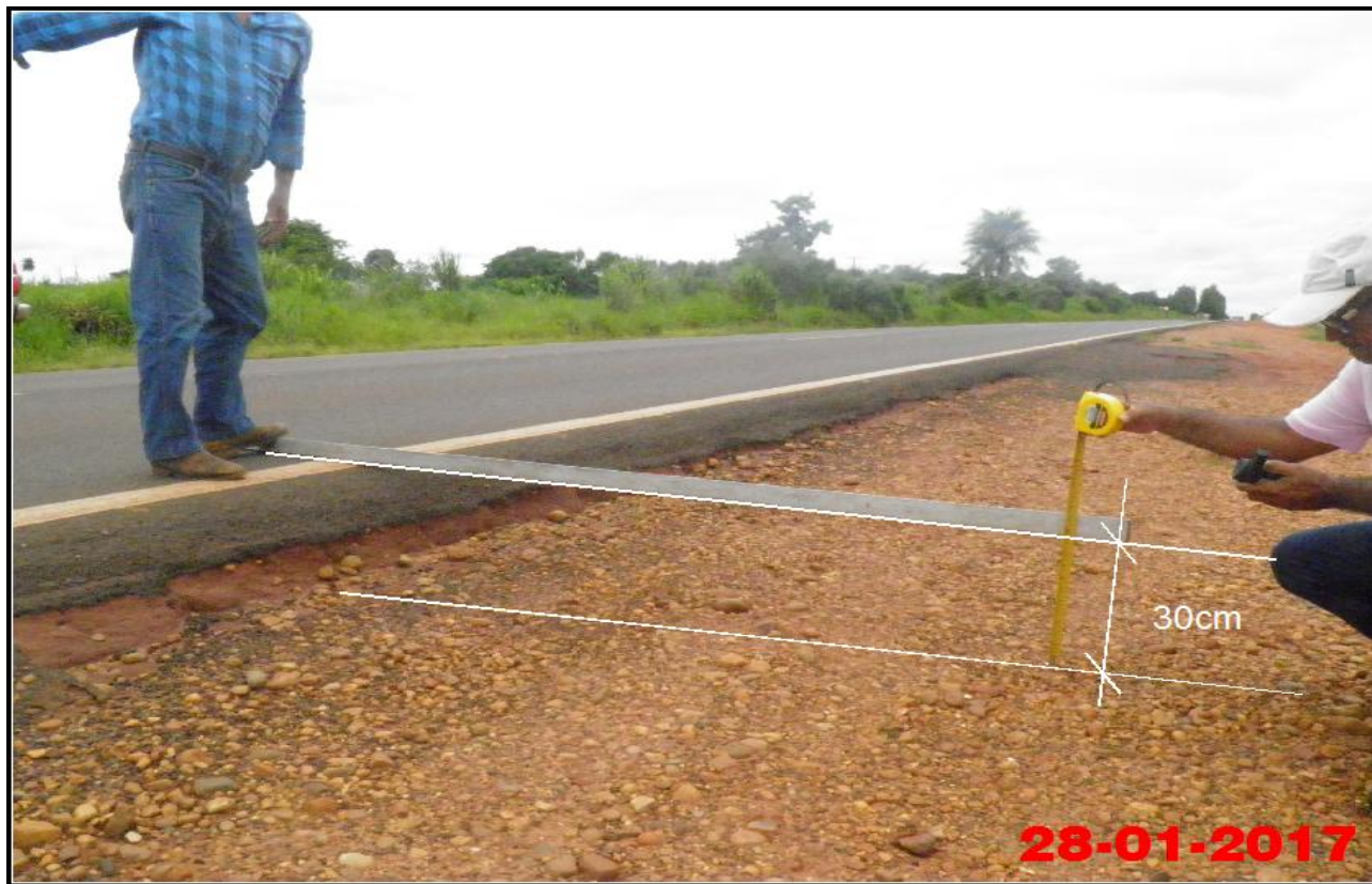
Foto 20 – Vista geral do desnível da Rodovia Arlindo Bétio (SP-613) com o seu acostamento do lado esquerdo no sentido à Rosana.
