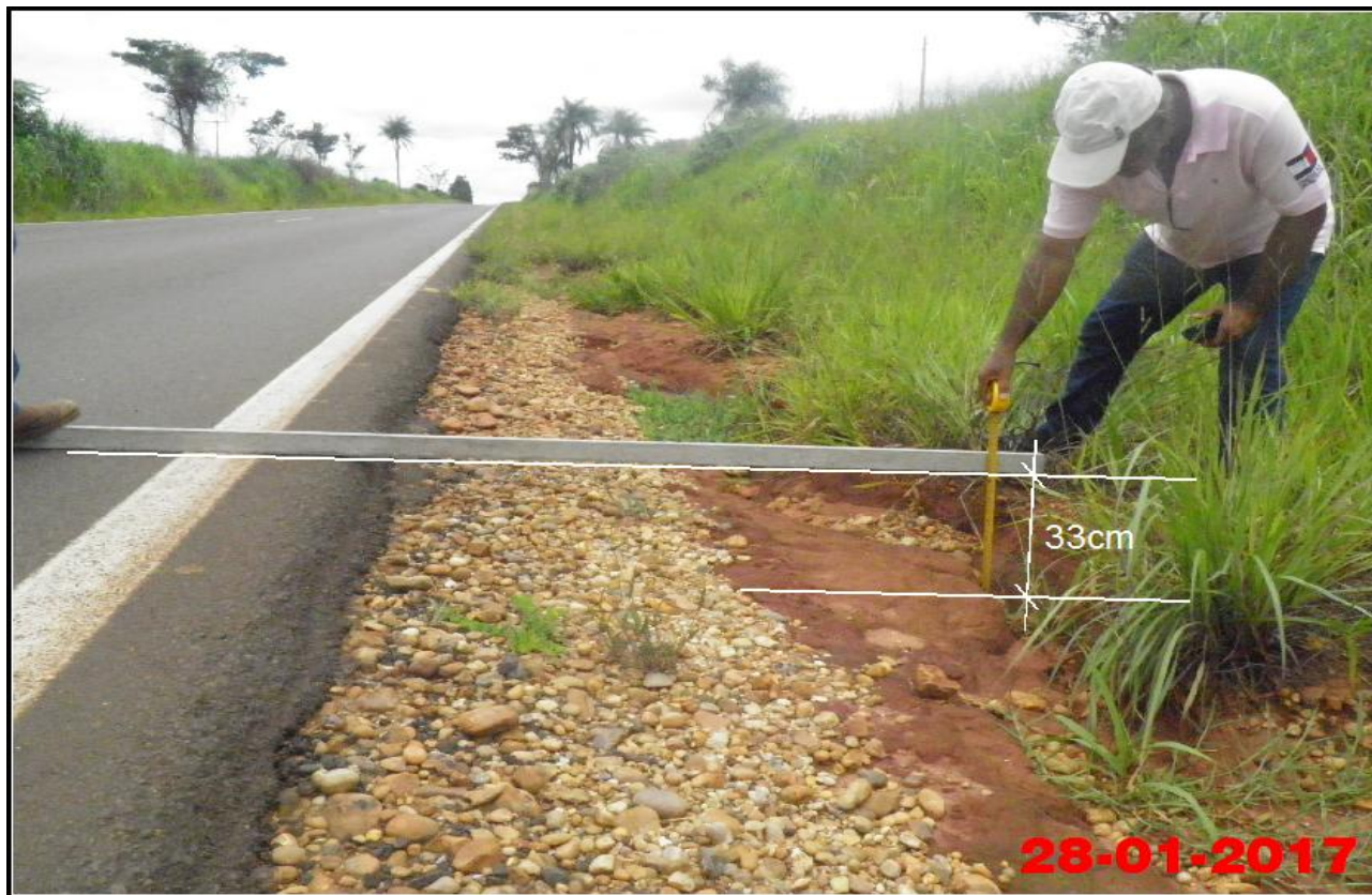
Foto 25 – Vista geral do desnível da Rodovia Arlindo Bértio (SP-613) com o seu acostamento do lado esquerdo no sentido à Rosana.
