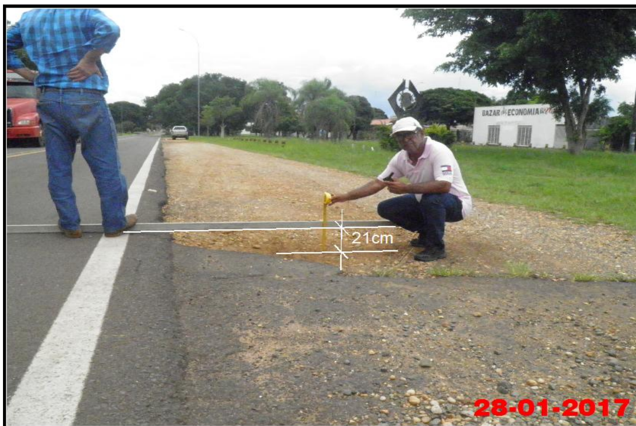
Foto 34 – Vista geral do desnível da Rodovia Arlindo Bétio (SP-613) com o seu acostamento do lado direito no perímetro urbano de Primavera sentido à Rosana.
