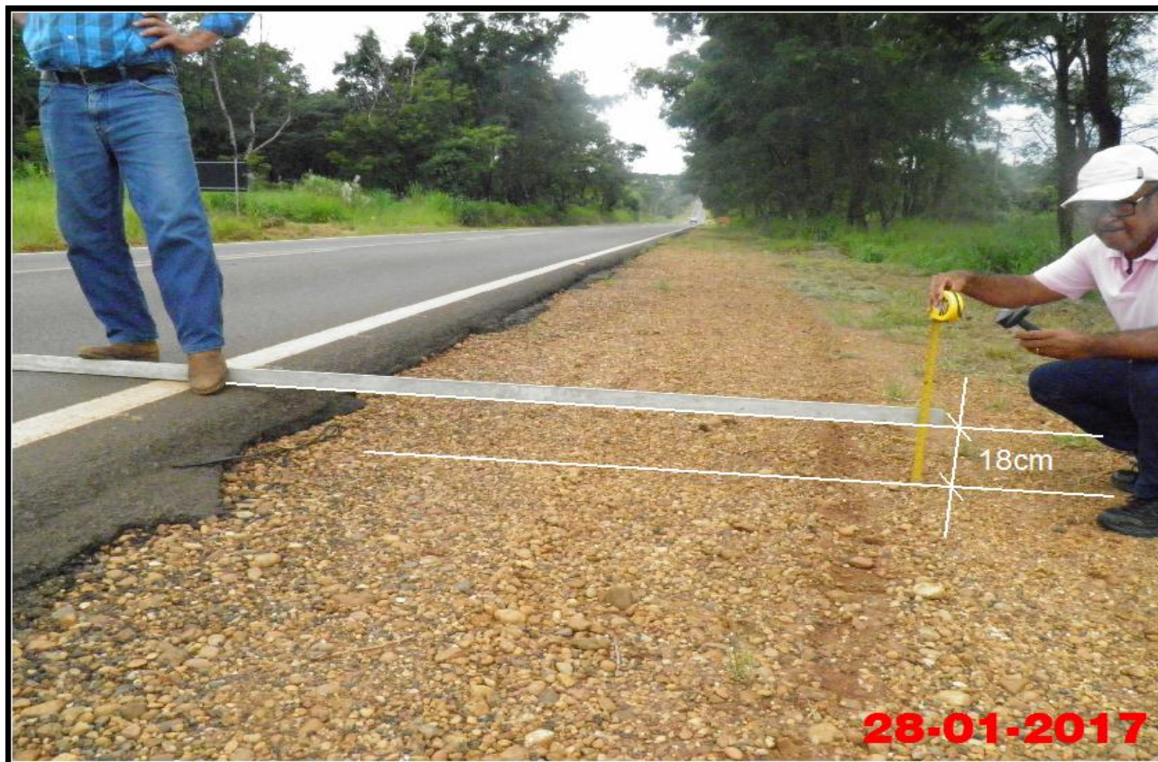
Foto 03 – Vista geral do desnível da Rodovia Arlindo Bértio (SP-613) com o seu acostamento do lado esquerdo no sentido à Rosana.
