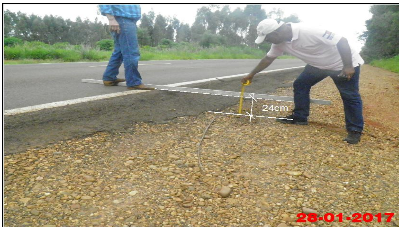
Foto 22 – Vista geral do desnível da Rodovia Arlindo Bértio (SP-613) com o seu acostamento do lado esquerdo no sentido à Rosana.
