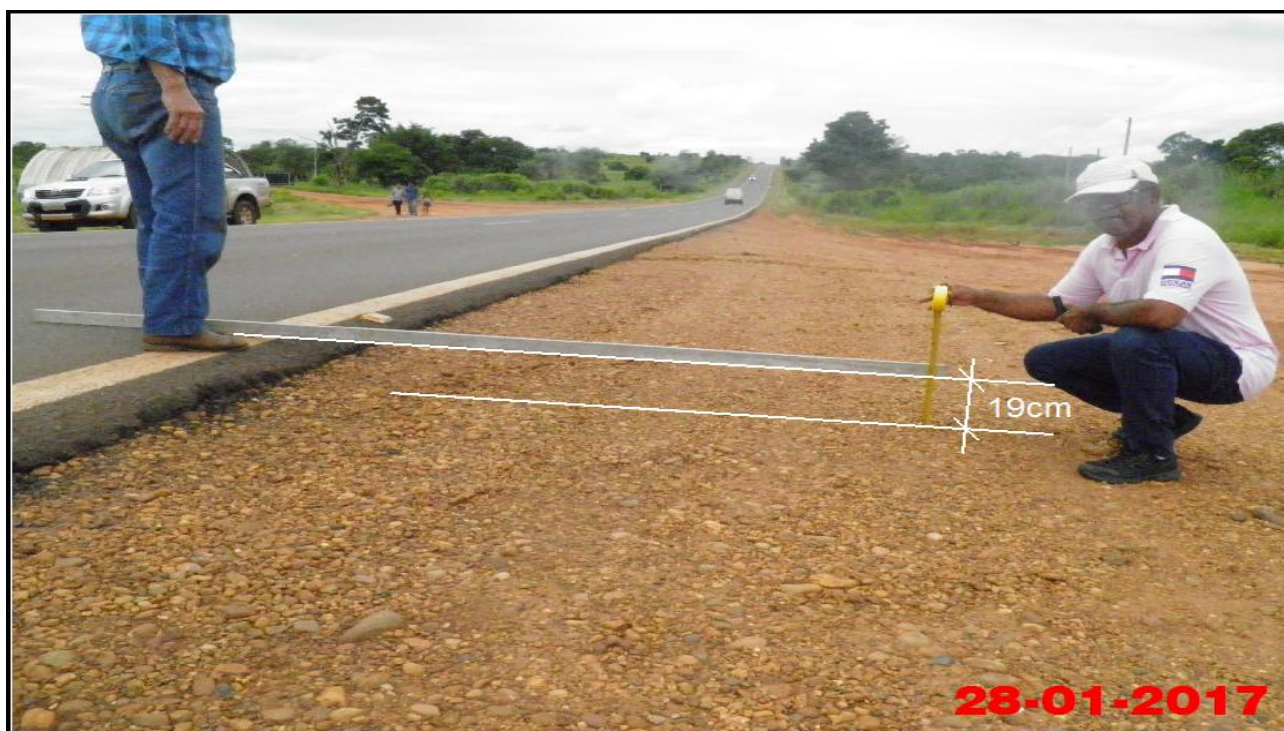
Foto 10 – Vista geral do desnível da Rodovia Arlindo Bértio (SP-613) com o seu acostamento do lado esquerdo no sentido à Rosana.
