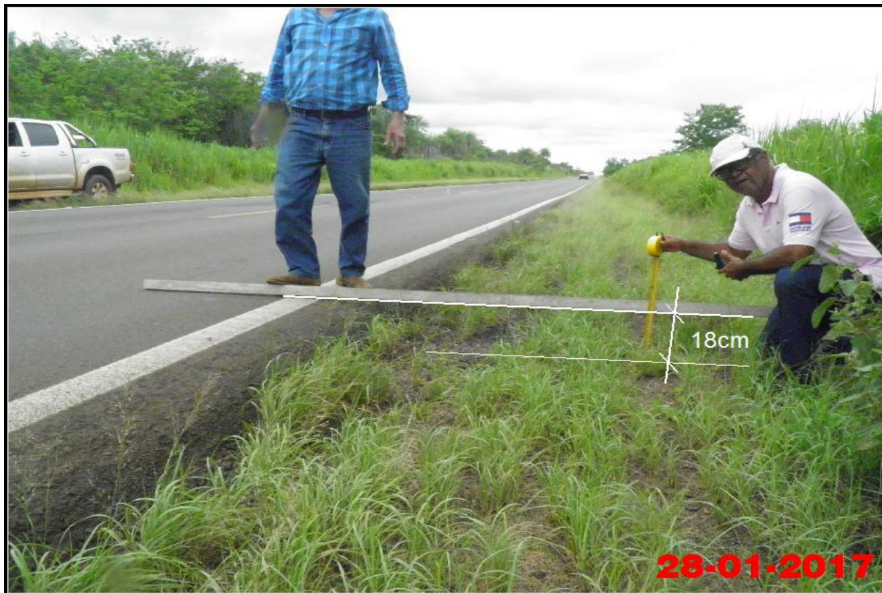
Foto 31 – Vista geral do desnível da Rodovia Arlindo Bértio (SP-613) com o seu acostamento do lado esquerdo no sentido à Rosana.
